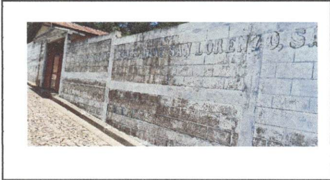
Foto 2. pinturas en muros exteriores.
