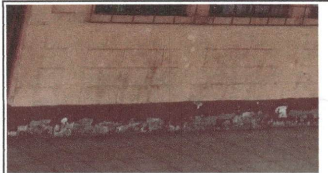
Foto 3. Pinturas en muros interiores
