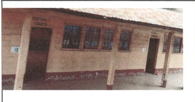
Foto 4. Pinturas en muros exteriores
