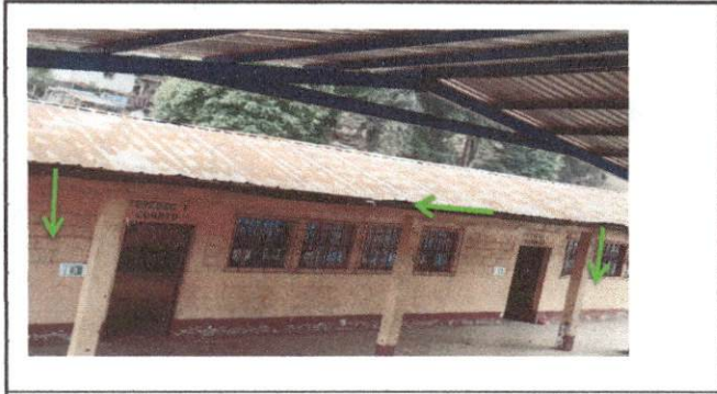
Foto 2. Canales y bajadas de agua pluvial en modulo de agua
