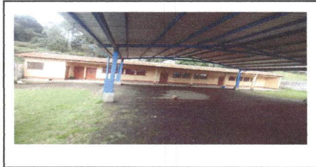
Foto 5: Instalación de lámina troquelada
