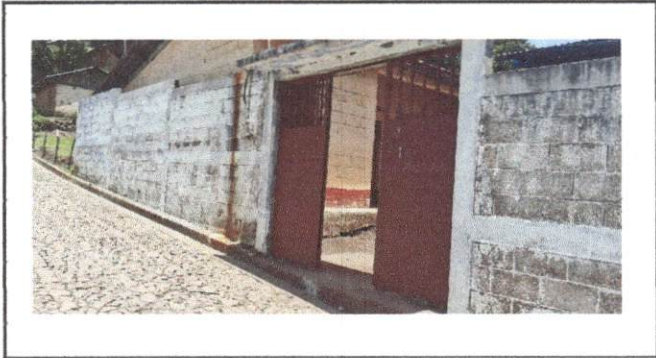
Foto 1. pinturas en muros exteriores.
