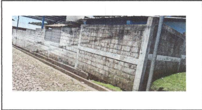
Foto 3. pinturas en muros exteriores.
