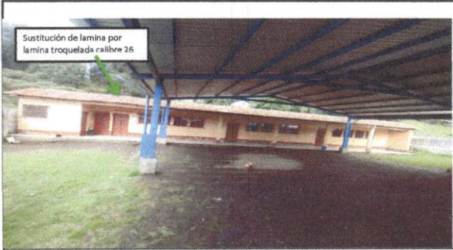
Foto 1. Sustitución de lámina por lamina troquelada aluzinc.
